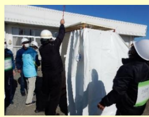
於保:仮設トイレ組み立て
