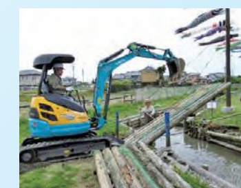
重機の扱いも手慣れたもの。本格的な補修工事でした。
