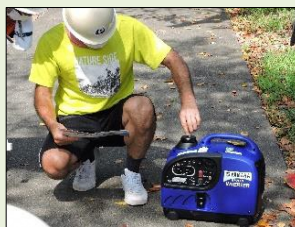
インバータ発電機点検
