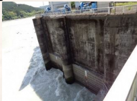
↑ 船明ダム取水口
