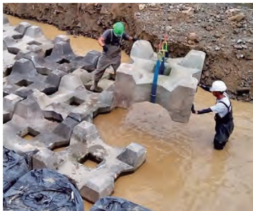
6月26日 根固めブロックの設置
