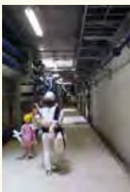
▲地下管廊の見学の様子
