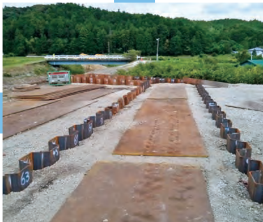
6月21日 堤防に鋼矢板の設置
