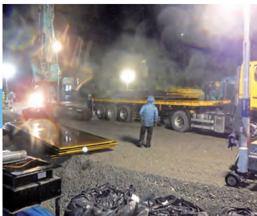
6月8日 仮設道路の設置
