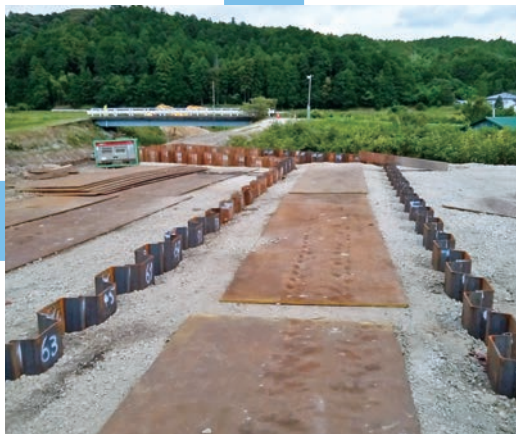
6月21日 堤防に鋼矢板の設置
