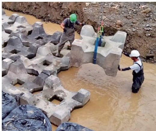
6月26日 根固めブロックの設置
