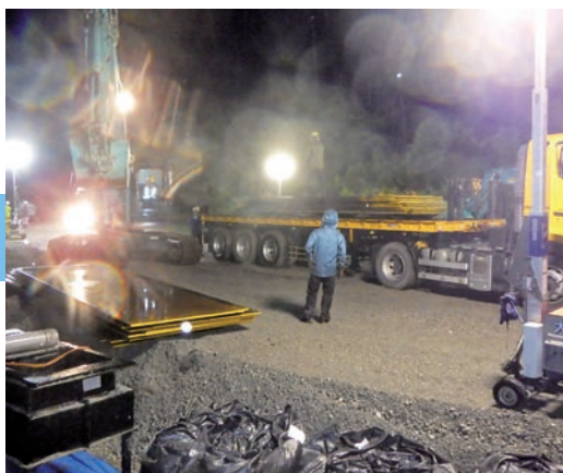
6月8日 仮設道路の設置
