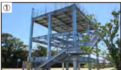
① ▲津波避難タワー
