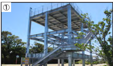
① ▲津波避難タワー
