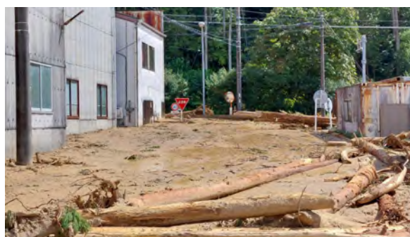
▲令和 4 年台風第 15 号による被害（神増地区）
