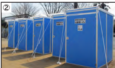
② ▲災害用マンホールトイレ
