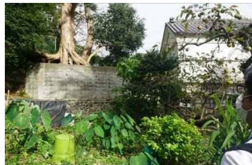
北側擁壁の現況 (西から)
