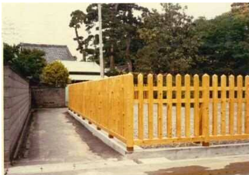
昭和 53 年度環境整備工事 (柵 竣工)
