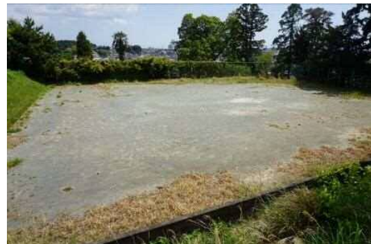
テニスコート跡現況 北西より
