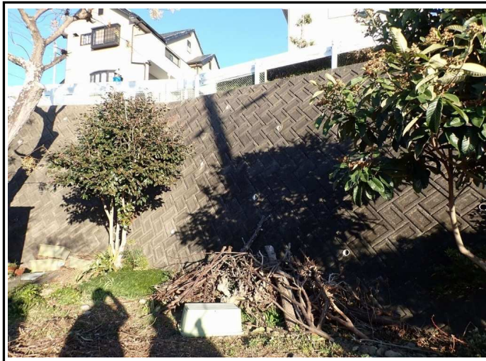
1 末端擁壁 全景 ブロック積擁壁工
