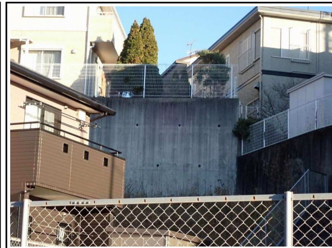
3 末端擁壁 全景 コンクリート擁壁工
