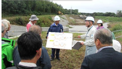
今之浦川の氾濫を防ぐ調整池の工事現場視察
