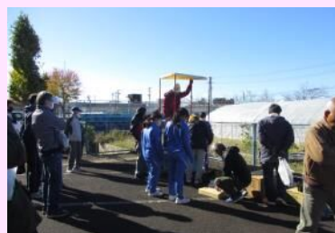
仮設トイレ設置（北小）
