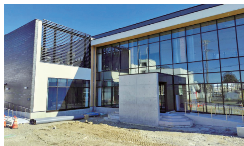
支所建設工事の様子（1月17日撮影）
