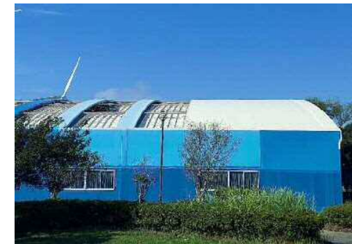
4番コート屋根部分(外観)
