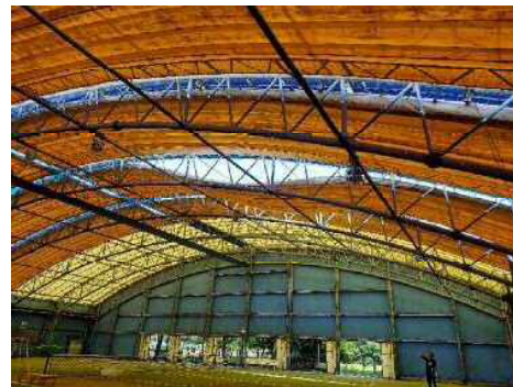
4番コート屋根部分(屋内)
