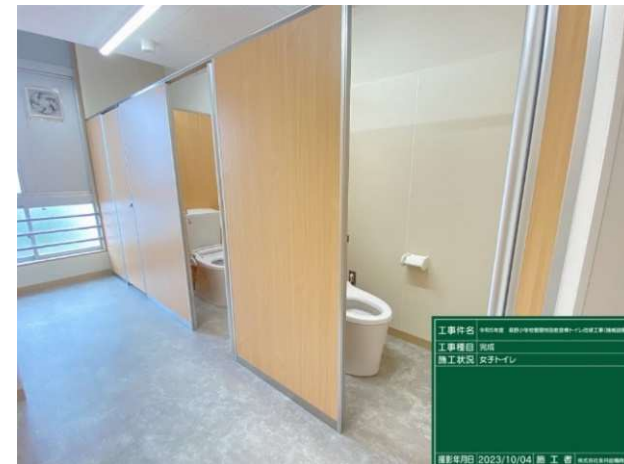
<改修後の洋式トイレの様子>
