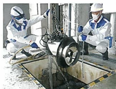
汚泥攪拌装置を点検中
