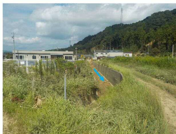
流域内の排水路の状況（土砂が堆積している）
