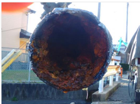
▲老朽管の撤去
