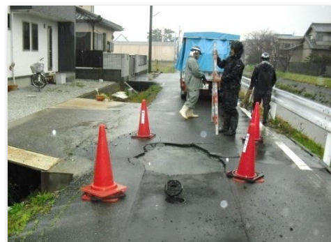
▲道路での緊急漏水修繕
