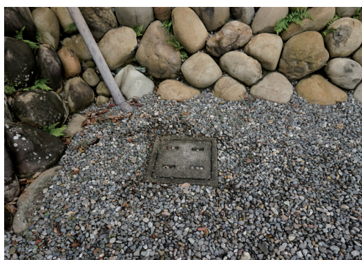
写真 39 集水桝 玄関東
