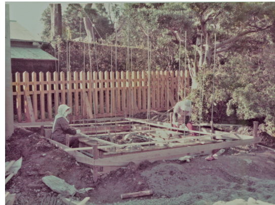
写真 43 昭和54年度 ポンプ小屋設置工事状況
