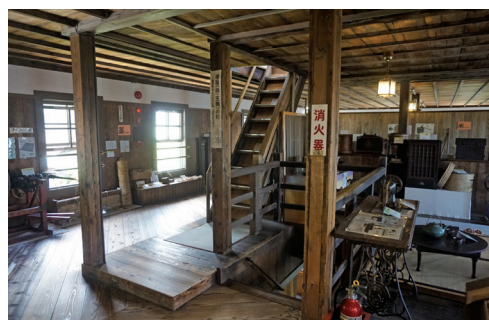
写真 34 3階に残された塔屋の柱
