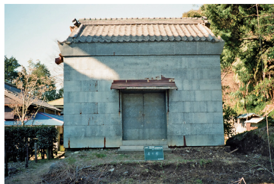
写真 49 修理工事前 平成4年
