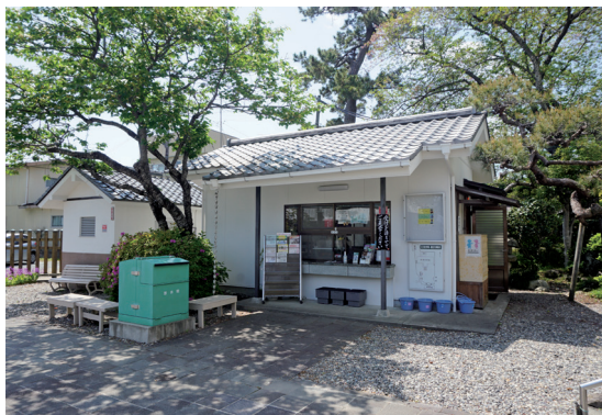
写真 36 管理棟（右）・ポンプ小屋（左奥）放水銃（左手前）
