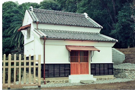
写真 47 磐田文庫 平成4年12月 修理竣工時
