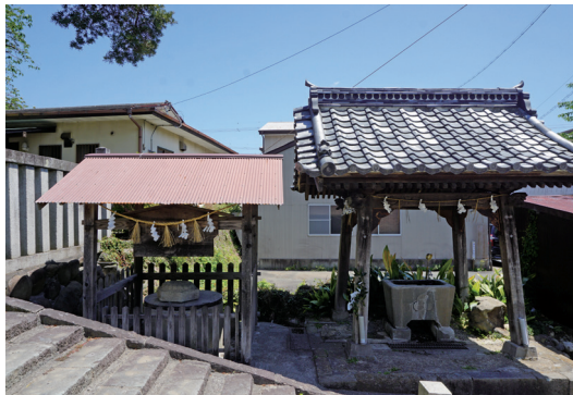
写真 61 井戸小屋及び手水舎
