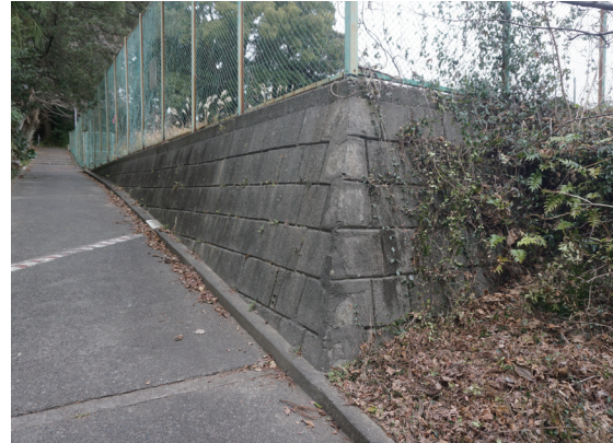
写真 74 テニスコート跡現況 南東擁壁
