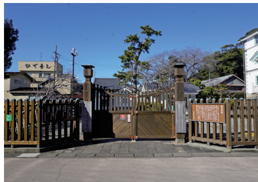
写真 84 門柱付近現況
