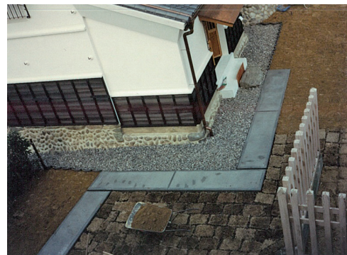
写真 86 環境整備工事竣工状況
