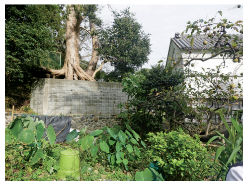
写真 87 北側擁壁の現況（西から）
