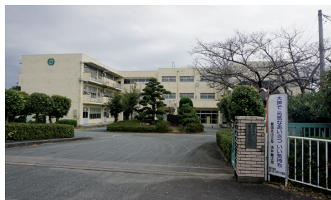
写真 16 城之腰校舎の現況 磐田北小学校（西門）
