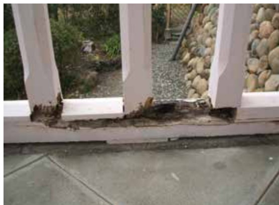
平成 22 年度修繕工事前（玄関ポーチ手摺）
