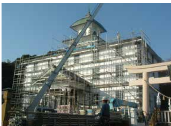
平成 18 年度校舎外壁等保存修理工事
