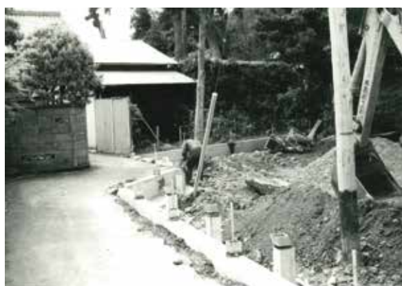
昭和 53 年度南側柵設置工事風景
