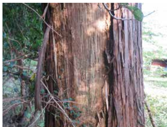
⑥スギ 倒木による建造物の影響および事故の危険
