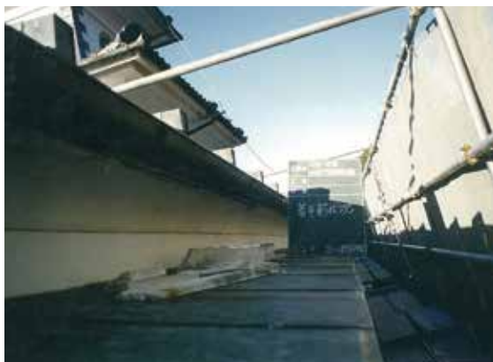
平成 11 年度修繕工事前（3 階軒先）
