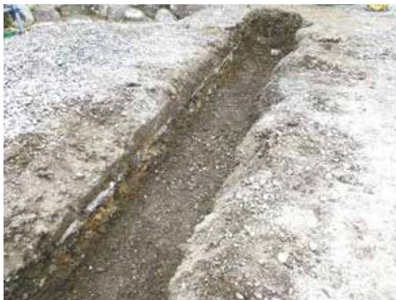
平成 28 年度消火設備改修工事 既存配管敷設状況
