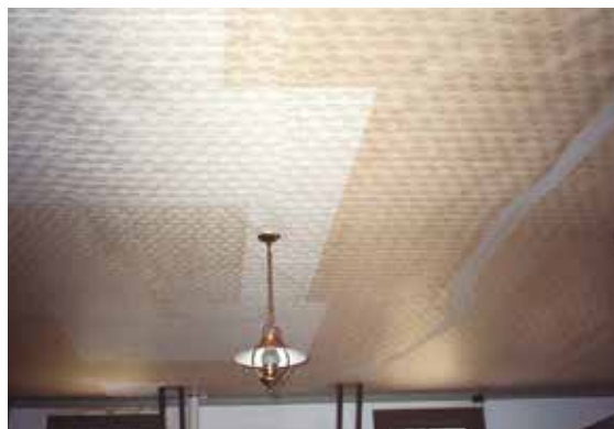
平成2年度修理工事前（天井）
