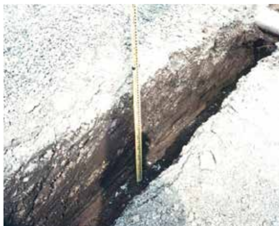
平成8年度排水設備改修工事
