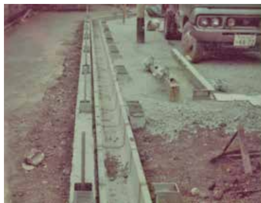
昭和 53 年度 史跡南端外柵・排水溝設置工事状況
