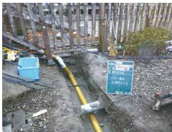
平成 28 年度消火設備改修工事 校舎南東配管敷設状況
