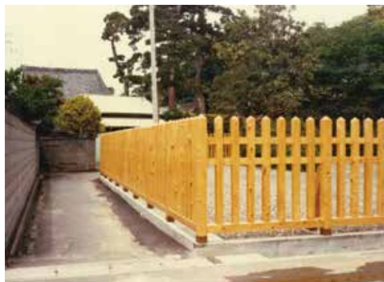
昭和 53 年度環境整備工事（柵） 竣工
