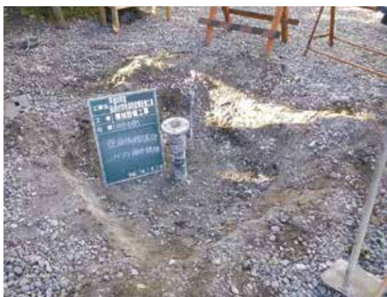
平成 28 年度消火設備改修工事 放水銃撤去状況
