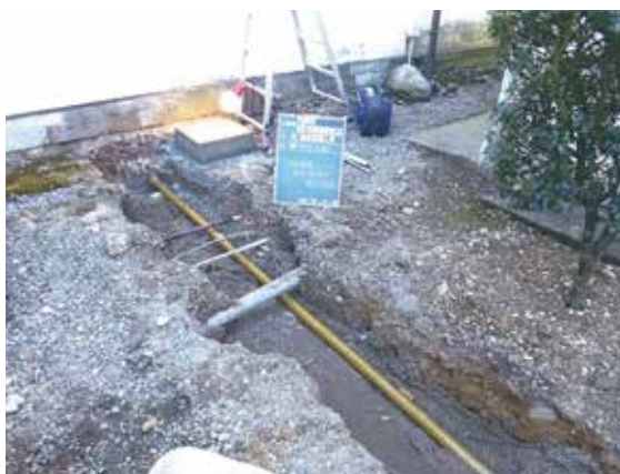
平成 28 年度消火設備改修工事 校舎北側配管敷設状況
