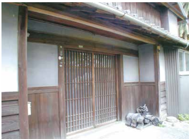
主屋玄関 南東から
