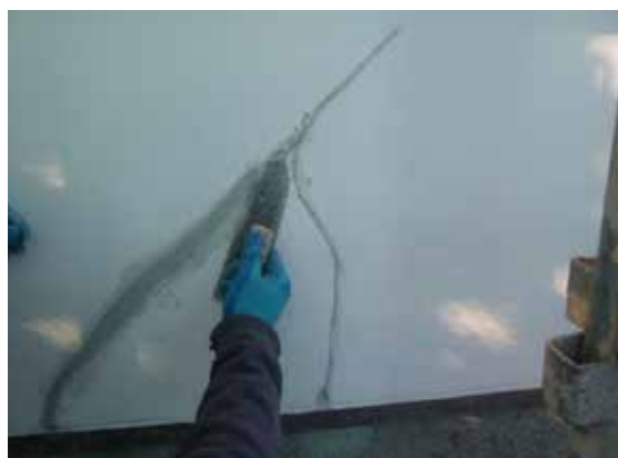
平成 18 年度 漆喰補修作業状況
