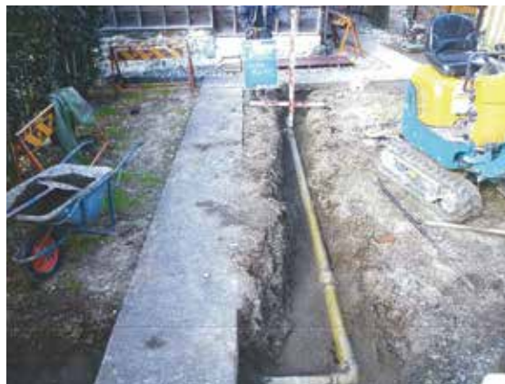
平成 28 年度消火設備改修工事 校舎北西配管敷設状況
