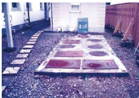
平成8年度排水設備改修工事 浄化槽撤去工事前
