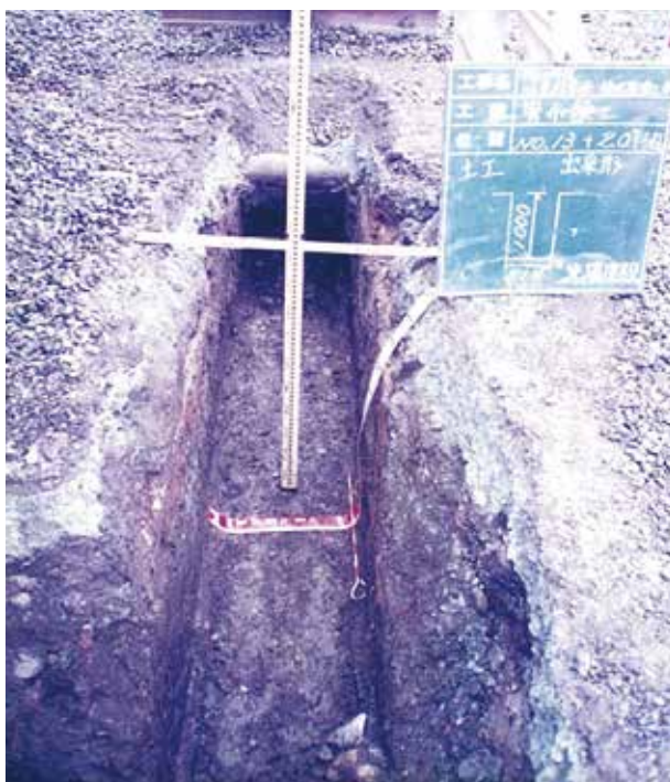
平成8年度排水設備改修工事
