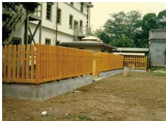
昭和 53 年度環境整備工事（柵） 竣工
