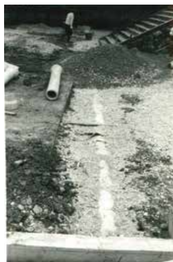
昭和 53 年度前庭内下水管敷設工事
