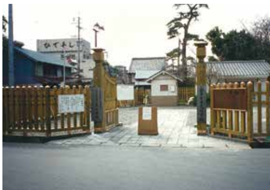
平成8年度施設改修工事 竣工
