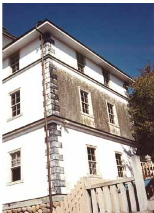
平成2年度修理工事前（外壁）
