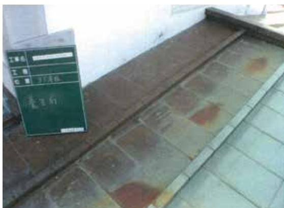
平成 24 年度修理工事（3 階屋根養生）
