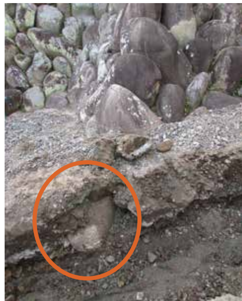
平成 28 年度工事立ち合い写真 に写った石垣下部の石
