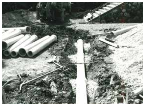
昭和 53 年度前庭内下水管敷設工事
