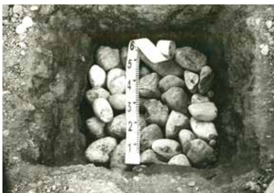
再設置時の栗石配置状況
