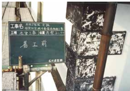
平成2年度修理工事前（外壁）
