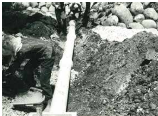
昭和 53 年度前庭内下水管敷設工事
