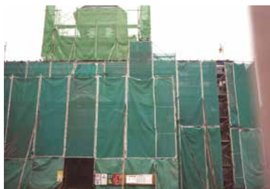
平成2年度修理工事（足場設置）
