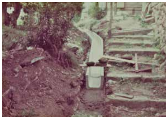
昭和 53 年度史跡西側排水溝設置状況
