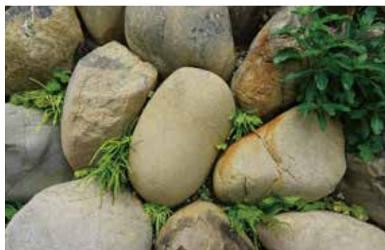
植物の繁茂状況
