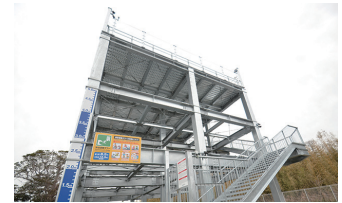
▲津波避難タワー
