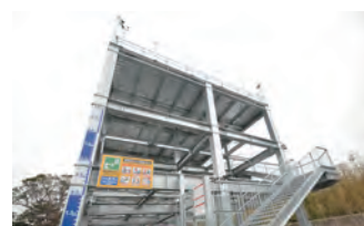
▲津波避難タワー
