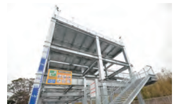
▲津波避難タワー
