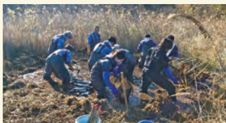
② 人工池の掘削作業
